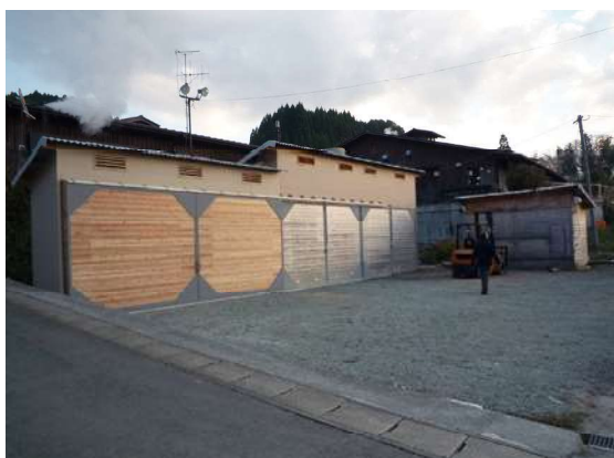
写真2 地熱を利用した乾燥施設 (熊本県小国町)
