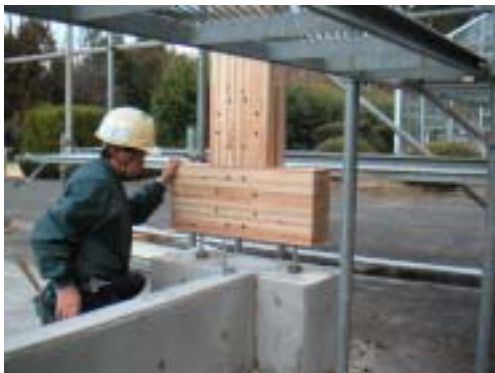
柱脚部の設置
