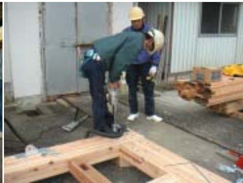
同時穴あけ作業
