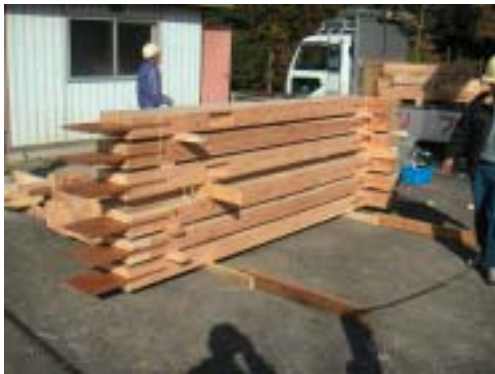
工場で加工された柱部分
