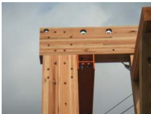
実大実験モニターに用いた強化LVL接合板と接合ピン
