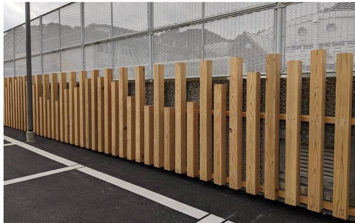
吉野町立 吉野さくら学園 駐車場横（2021年 施工）
