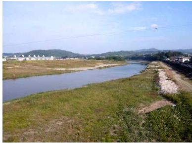
036 国道168号・大川橋 五條市4:河川への眺め
