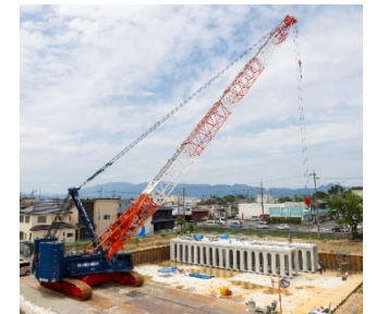
工事中の地下貯留施設(田原本町)
