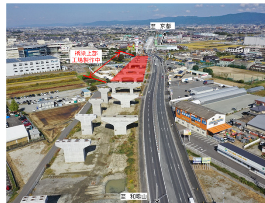
大和御所道路(橿原市新堂町)
