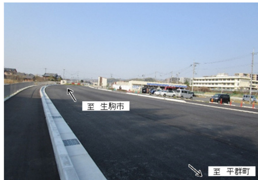
小平尾バイパスの工事状況
