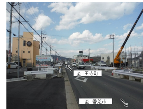
王寺・香芝王寺道路の工事状況
