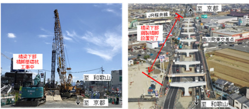
大和北道路(大和郡山市横田町)
