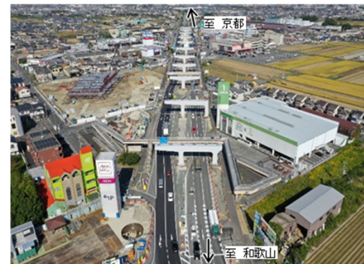
橿原市新堂町 本線部(橋梁下部工事)
