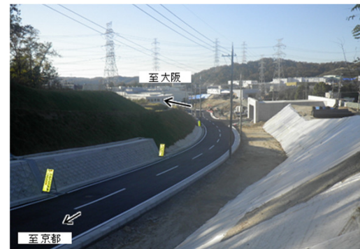
北田原地区(土工事)
