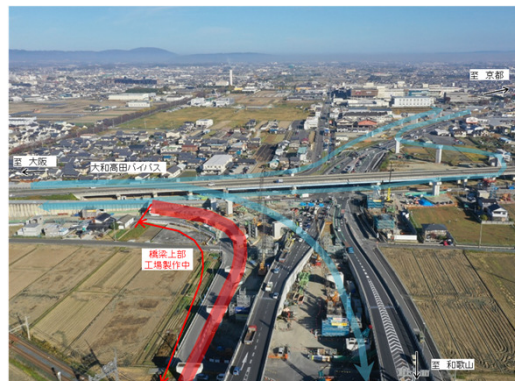
橿原市新堂町 ランプ部(橋梁下部工事)
