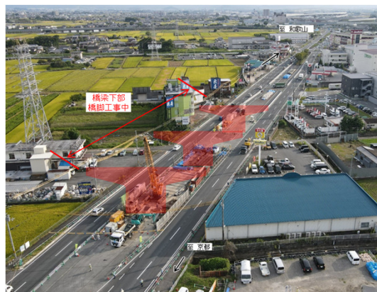
大和北道路(大和郡山市横田町)
