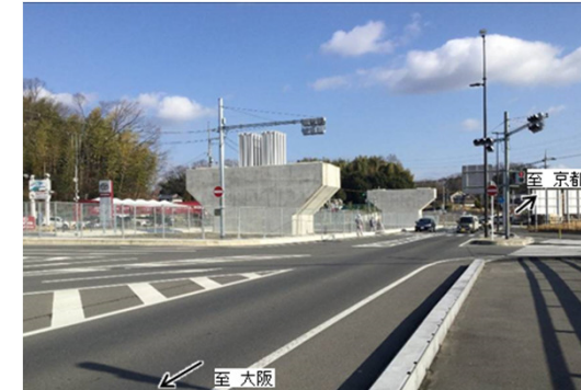
高山高架橋(橋梁下部工事)
