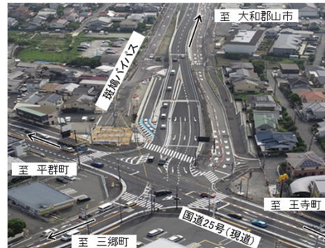
三室交差点の改良工事完成状況
