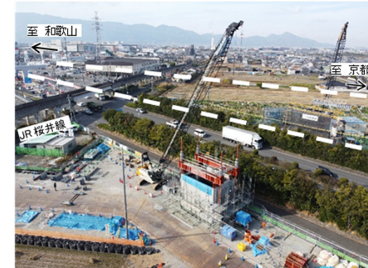
橿原市曽我町 本線部(橋梁下部工事)
