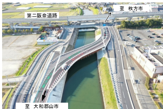
枚方大和郡山線(中町工区)南側(R元年度部分供用予定箇所)
