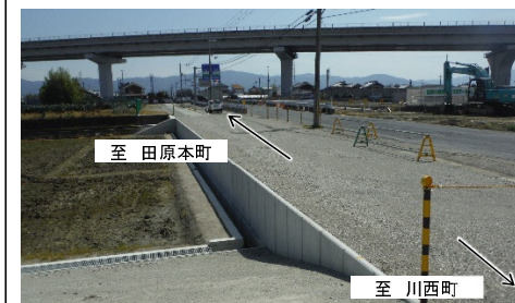
結崎田原本線(結崎～三河工区)南側
