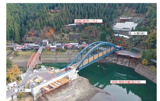
阪本工区 (北側の整備状況)
