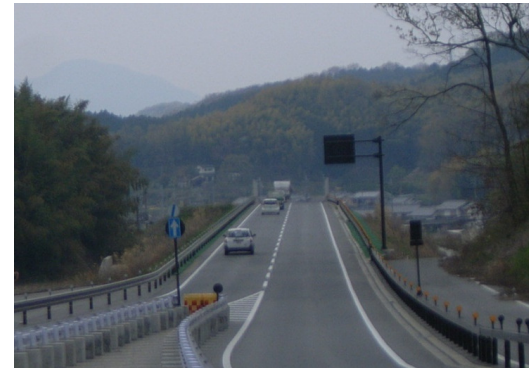
高取バイパス(供用済区間)
