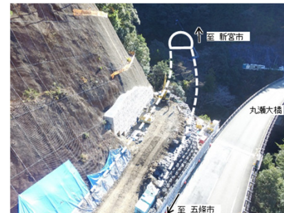
風屋川津工区(仮称)1号橋 (橋梁下部工事)
