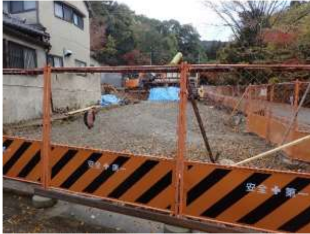
水谷神社近くの谷沿いの工事箇所
