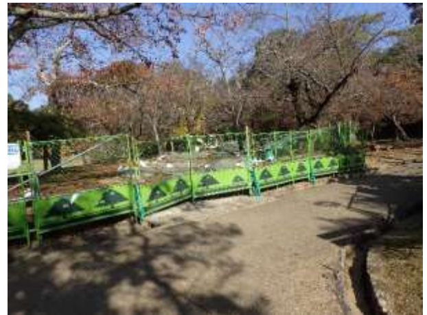
東塔跡園地の工事箇所
