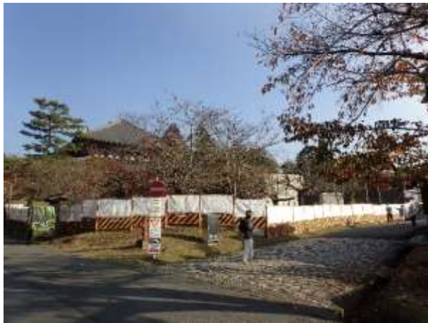
指図堂付近の工事箇所
