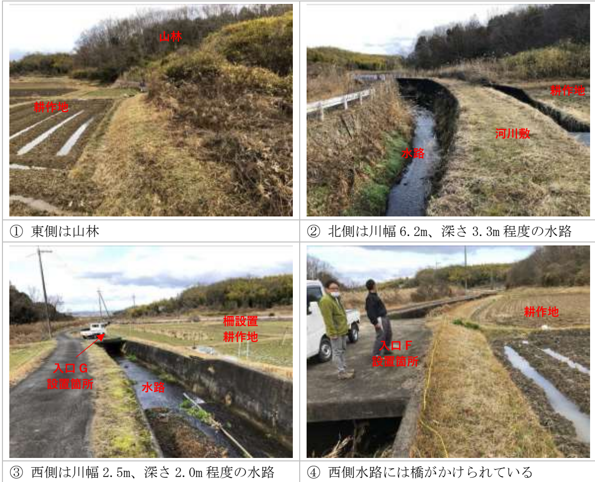
写真1 防鹿柵設置場所の状況（令和3年1月27日撮影） 番号①～④は、図2の「写真撮影方向」番号に対応している。
