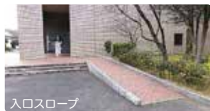
入口スロープ
