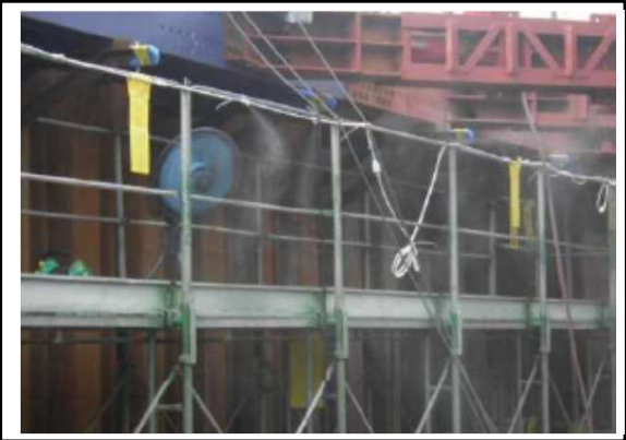
例) 仮締切内に扇風機とドライミスト設置
