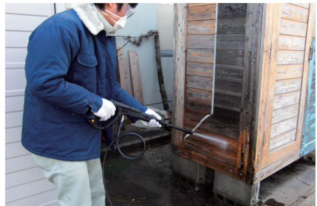
図1 (A)水圧洗浄機による水洗
