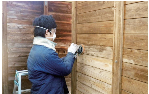
図2 (B)電動サンダによる研磨
