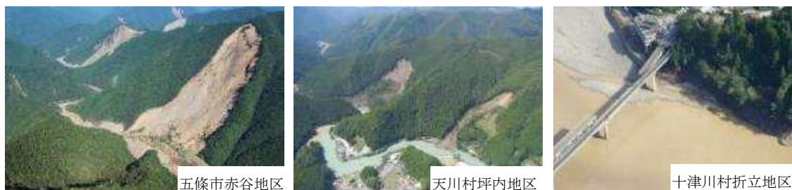
写真1 紀伊半島大水害の被害状況
