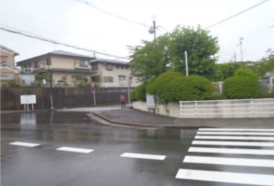
⑨ 防護柵がない
