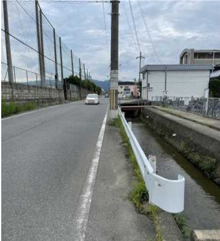
⑦ 交通量が多く、路肩が狭い
