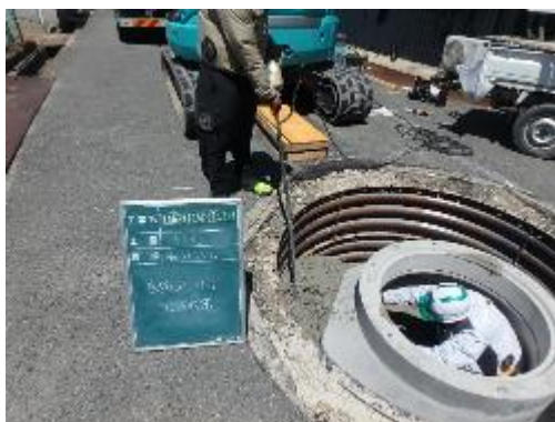
弁室のコンクリート打設状況
