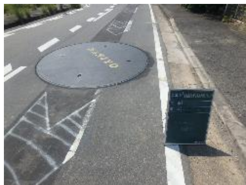
覆工板施工による交通開放
