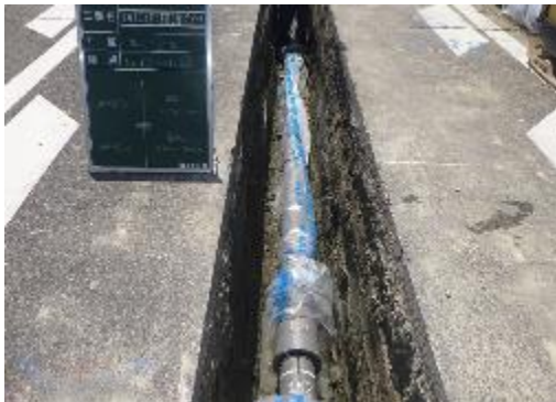
送水管埋設状況
