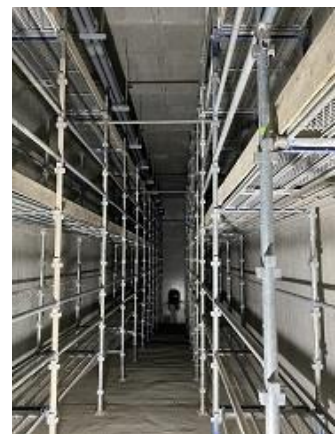
写真-5 箱桁内足場
