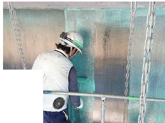
写真-3 炭素繊維シート貼付状況
