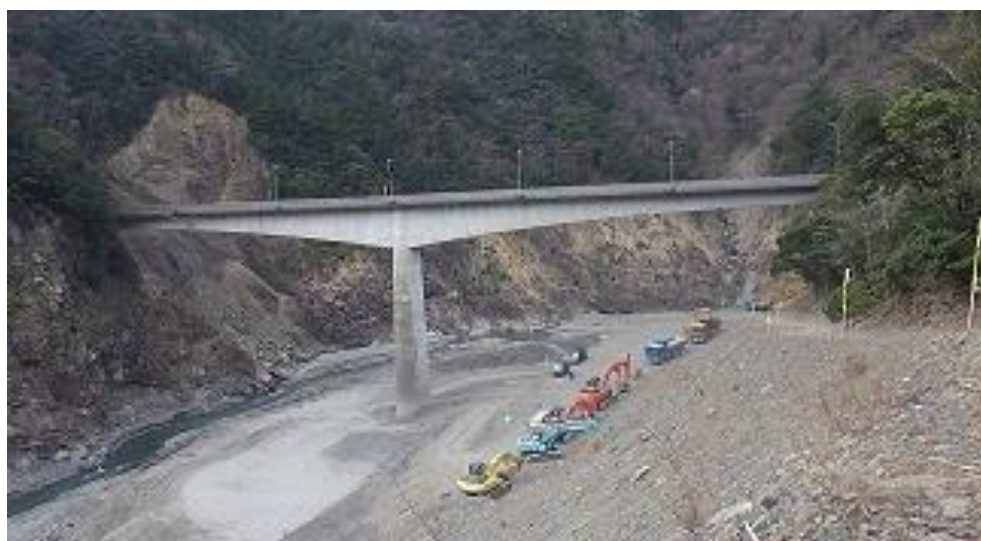
写真-1 小休場橋 全景
