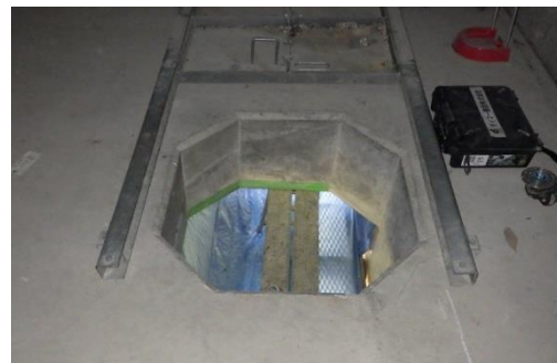
写真－2 管理孔(箱桁内部より)
