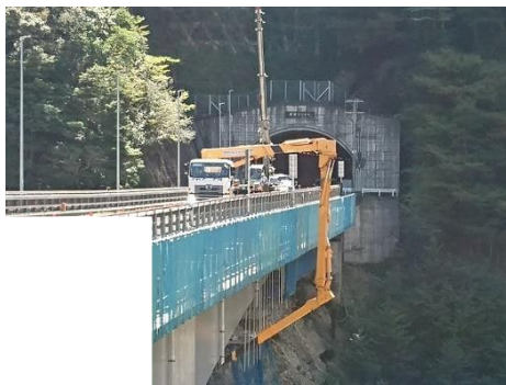
写真-4 大型の橋梁点検
