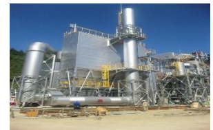
木質バイオマス利用施設
