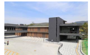
公共建築物の木造・木質化 (奈良公園バスターミナル)
