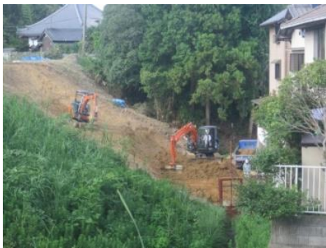
西日本豪雨被災ため池 (大和郡山市 大池) 防災重点ため池に追加
