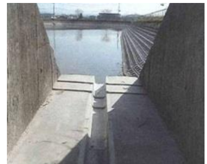
大和高田市 礪野池 治水利用のための洪水吐の改良
