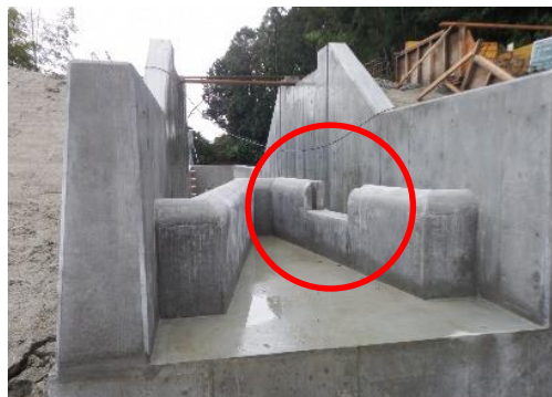
改修時に洪水吐を改良 葛城市 大屋下池 R1実施
