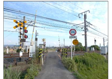
D 中八条踏切道 (農道)
