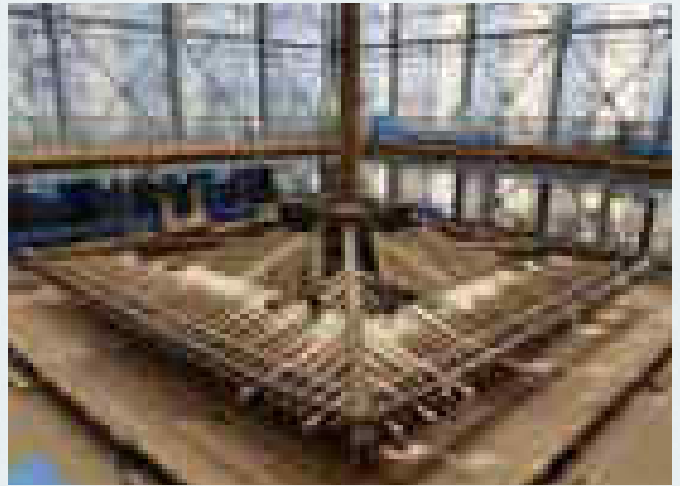
薬師寺東塔の修理 (薬師寺提供)
