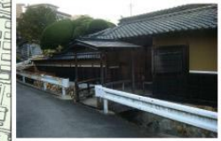
26 前川家 萩原宿の北端にある大和棟の屋敷で、門屋の屋根橋も残る。
