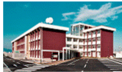
集約化した庁舎 (櫃原総合庁舎)
