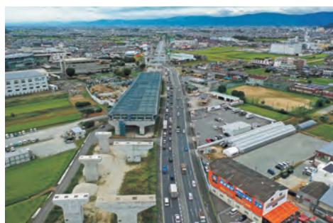
京奈和自動車道(橿原北IC~橿原高田IC)高架橋上部工事施工中(R3.9)
