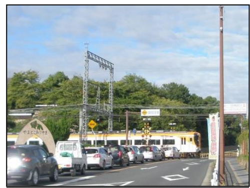
写真2: (主)奈良大和郡山斑鳩線 (九条第9号踏切道・東側)
