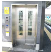
鉄道駅におけるエレベーターの設置(近鉄前栽駅)
