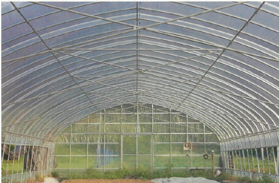
クロスバーによる補強 (大和野菜研究センター内に設置)
