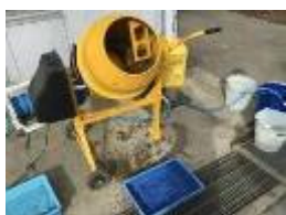
コンクリートミキサーで 3 分間攪拌
