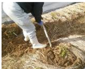
手作業による掘り上げのようす
