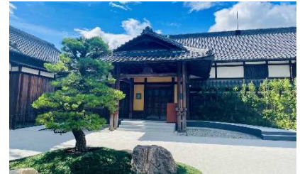
宿泊施設のエントランスに旧知事公舎を活用 (吉城園周辺)
