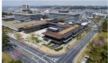
完成した奈良公園バスターミナル
