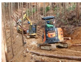
奈良型作業道
