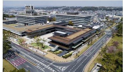
完成した奈良公園バスターミナル
