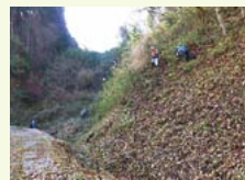
クロガリ整備の作業
