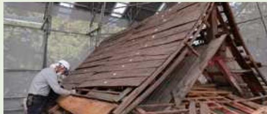
文化財建造物の保存修理の様子
