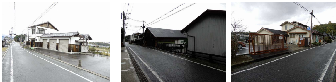
写真 8-2 内郭南方地区の様子
