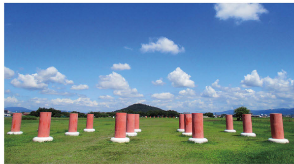
藤原宮跡では、発掘調査成果をもとに当時の建物の推定位置と規模を復元柱で示しています。(橿原市提供)
