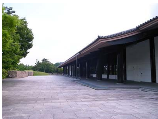
写真 奈良県新公会堂
