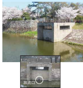
ため池の治水利用(大和郡山市鬮堀池)
