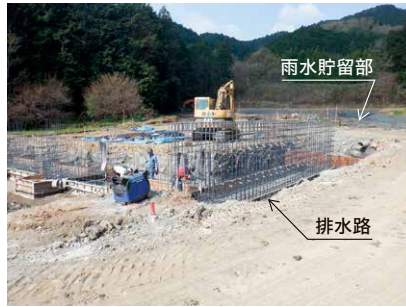
工事状況(今住流域貯留施設) (御所市)
