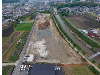
工事状況(葛下流域貯留施設) (王寺町)
