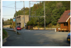
36 国道との合流点 ここから街道は国道と近鉄の線路と重なる。
