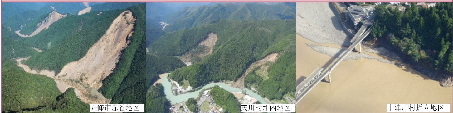
紀伊半島大水害の被害例
