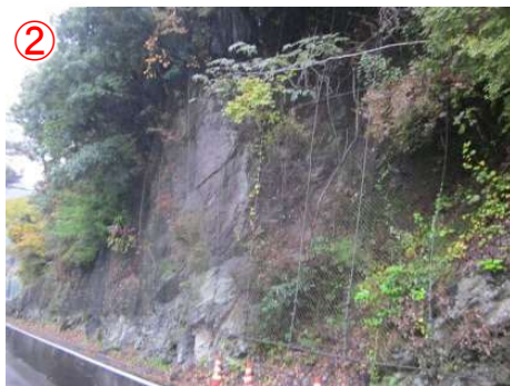
② 岩盤崩落の危険性が高い箇所
