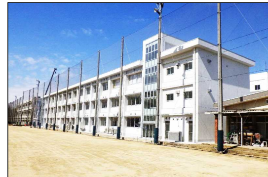
王寺工業高校 R4. 3月 工事完了
