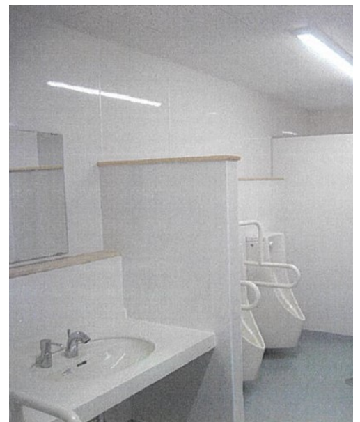
トイレ（改修後）
