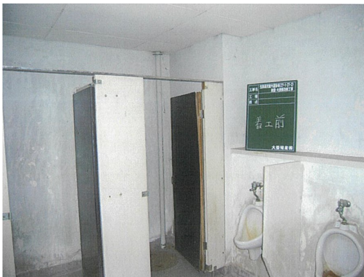
トイレ（改修前）
