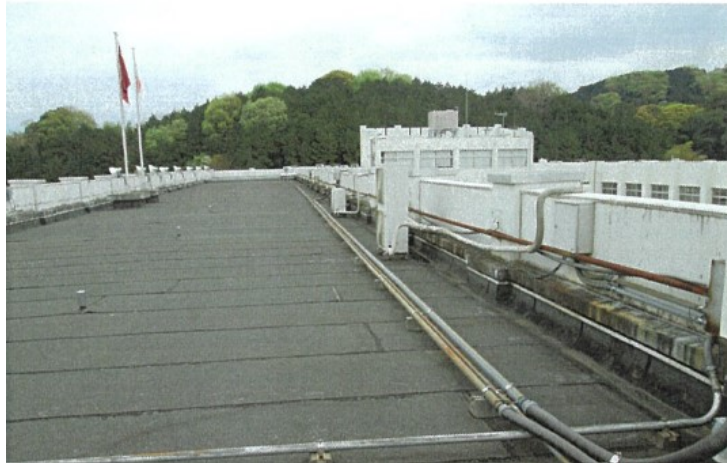
改修前の屋上
