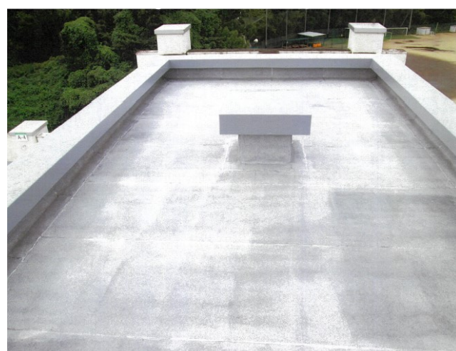
階段室屋上（改修後）
