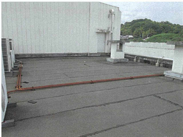
管理棟屋上（改修前）
