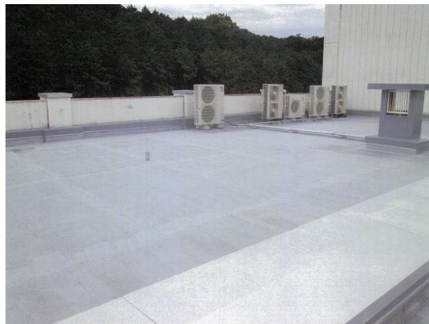
管理棟屋上（改修後）
