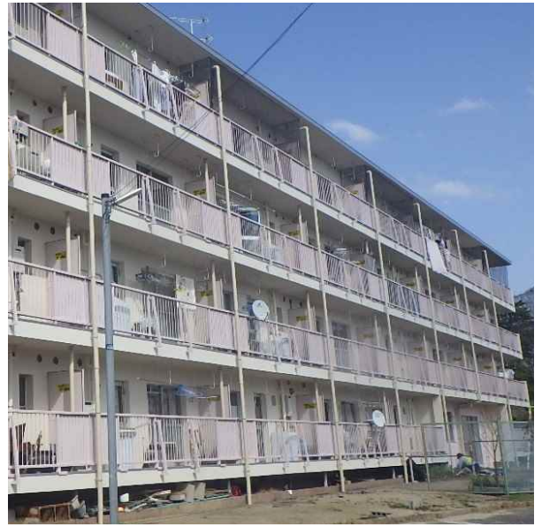
外壁改修(改修後)
