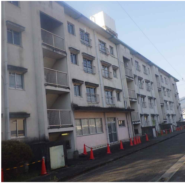
外壁改修(改修前)
