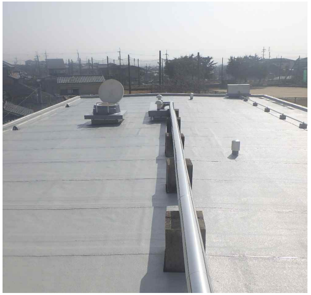
屋上防水(改修後)
