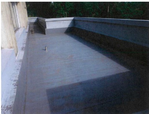
2階屋上（改修前）
