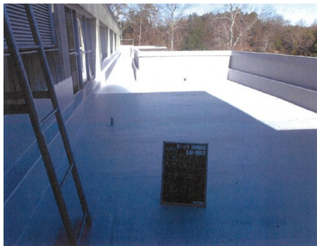
2階屋上（改修後）
