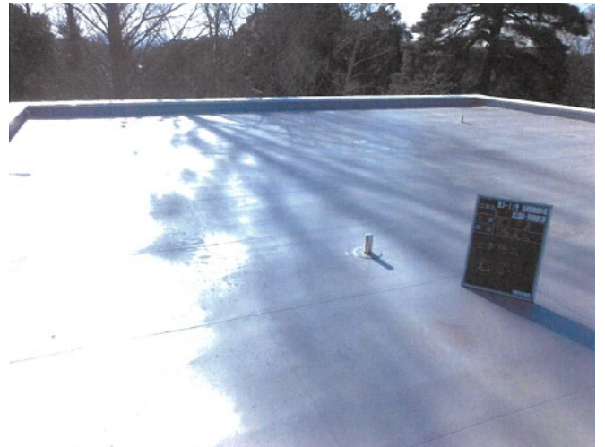
3階屋上（改修後）
