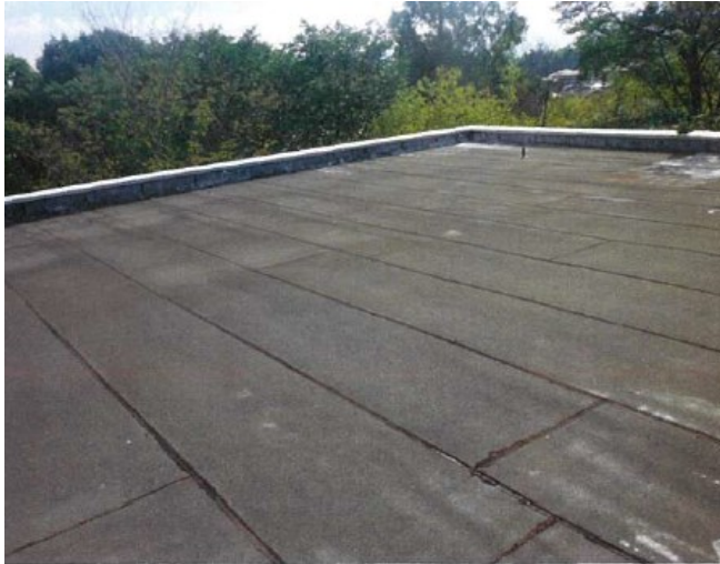
3階屋上（改修前）
