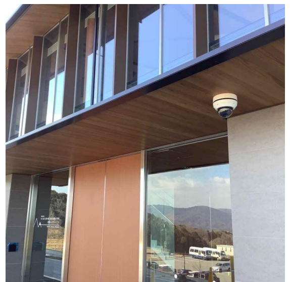
入口 (監視カメラ)
