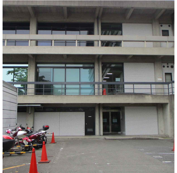
外壁改修（改修後）
