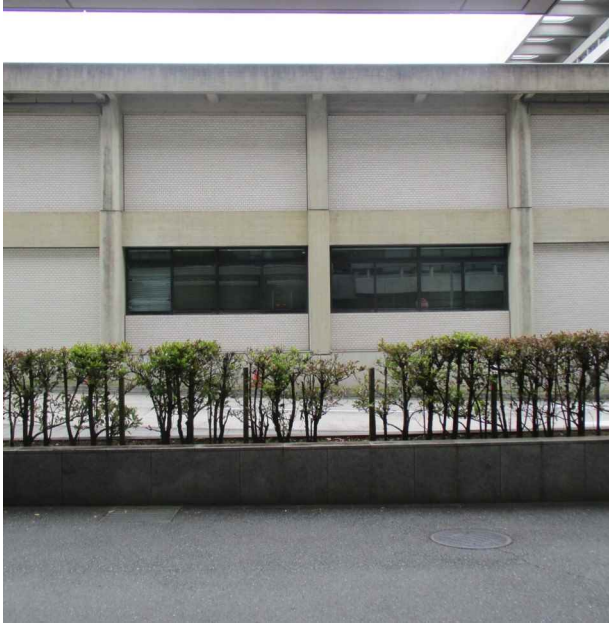
外壁改修（改修前）
