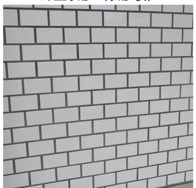
外壁改修（改修後）
