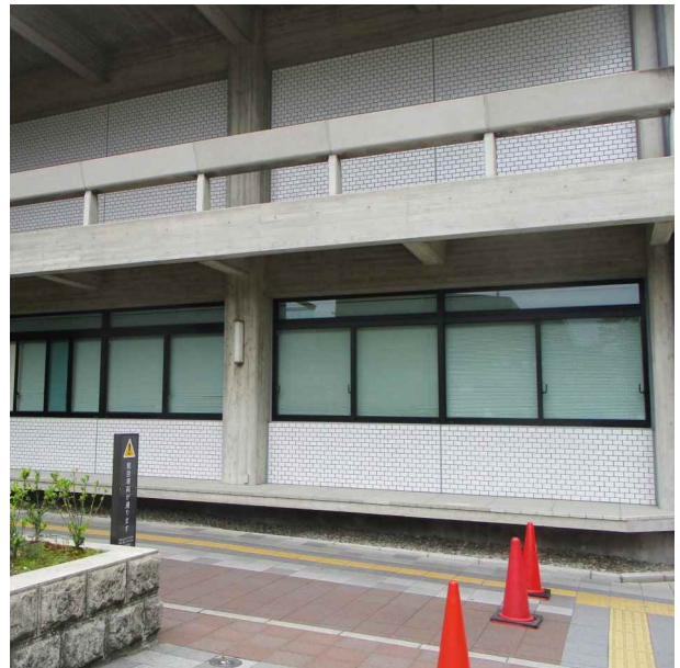
外壁改修（改修後）
