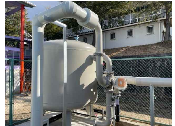
ろ過器（施工後）
