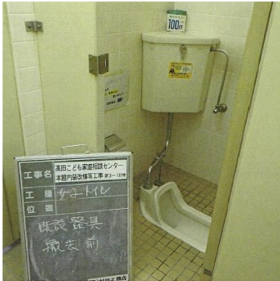
女子トイレ (改修前)
