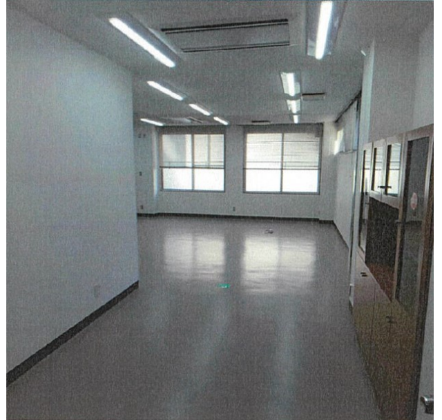
事務室・所長室（改修後）
