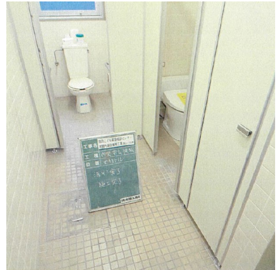
女子トイレ (改修後)
