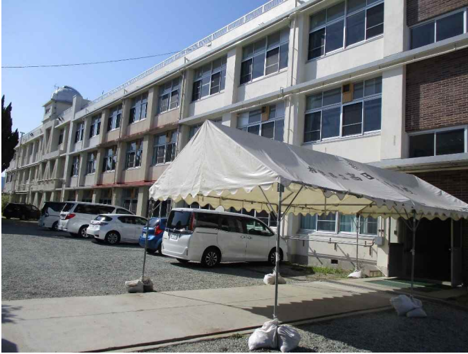
南面耐震20-1 (改修前)
