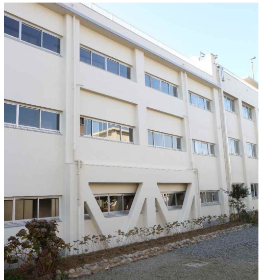
北面耐震 (改修後)
