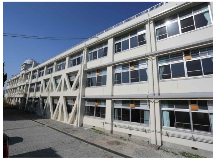
南面耐震20-1 (改修後)
