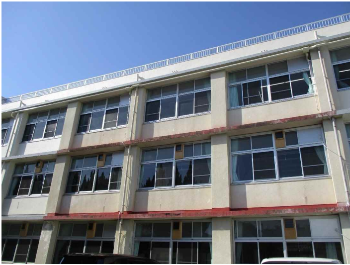
南面耐震20-2 (改修前)
