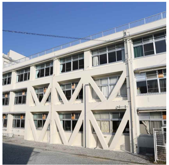
南面耐震20-2 (改修後)
