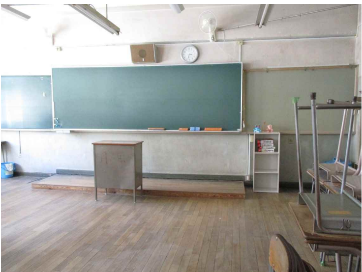
教室内 (改修前)
