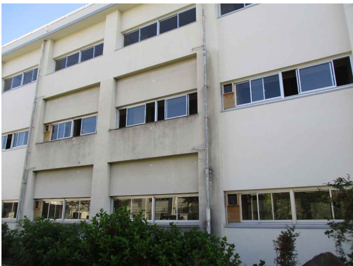
北面耐震 (改修前)
